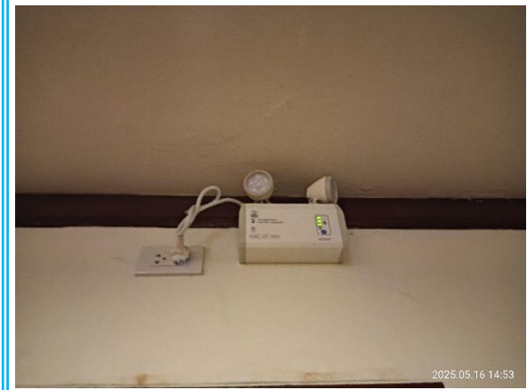
รูปที่ 3-56 ไฟส่องสว่างฉุกเฉิน
