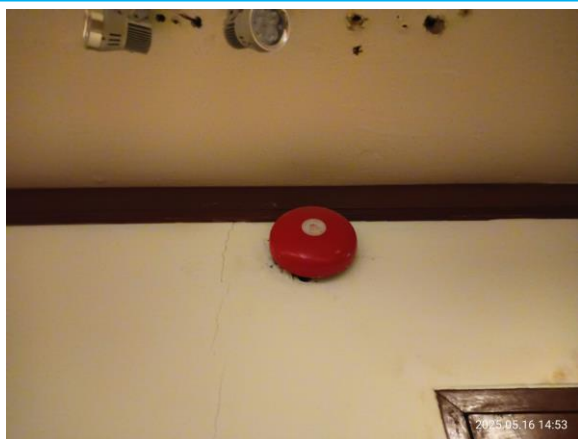
รูปที่ 3-55 อุปกรณ์แจ้งเหตุเพลิงไหม้ด้วยเสียง
